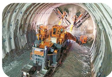
古河ロックドリル株式会社は、清水建設と共同で山岳トンネル工事の安全性や生産性アップを目的に遠隔でのロックボルト打設装置（ボルティングユニット）を装備した「2ブームロックボルト打設専用機」による遠隔施工システムを構築しました。東北陸自動車道「真木トンネル工事」（富山県）に導入され、サイクルタイムの短縮や施工の省人化に対する効果が確認されました。打設専用機に装備するボルティングユニットは穿孔用装置やモルタル充填用装置、ロックボルト格納用マガジン、ロックボルト押し込み用装置で構成。オペレーターが2つのブームを遠隔操作することで、穿孔からモルタルの充填、ロックボルトの挿入に至るまで一連の打設作業を完全に機械化します。災害リスクの高い切羽直下での人力作業をなくすだけでなく、一般工法との比較でサイクルタイムを約10%短縮できます。
