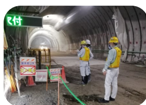
【坑内パトロール】
