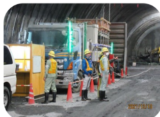
【坑内パトロール】
