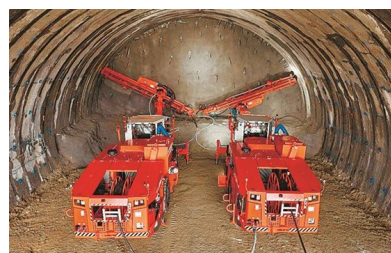
宇治田原トンネル東工事における ロボルト施工状況
