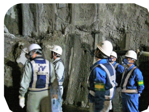
坑内粉じんパトロール状況
