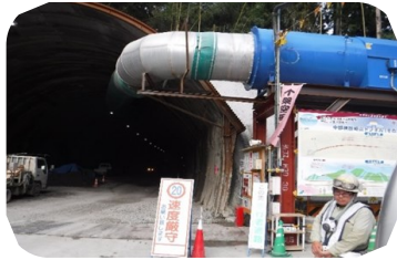
(元請所長による工事概要説明)
