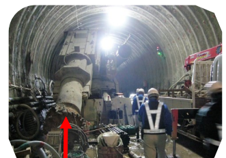
自由断面掘削機
