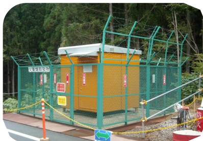
火薬取扱所(外柵)
