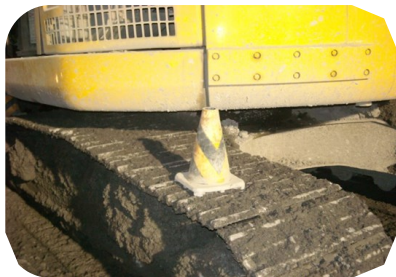
重機稼働時の周囲確認対策
