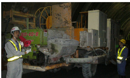
(コンクリート吹付け機研修)
