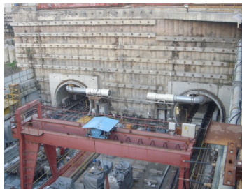
イェニカブ駅TBM2, 3号機発進基地
