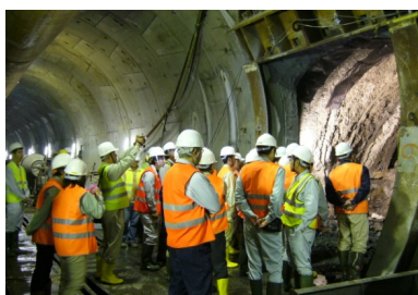
TBM工区避難通路掘削
