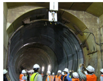
沈埋函とTBM接合点見学
