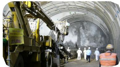
箕面トンネルは全長約5000mで2工区に分かれており、今回の見学・研修現場はその東側工区です。特長は坑口部約300mが箕面断層帯の不良地山で機械掘削を行い、その後は発破掘削を行っています。掘削ズリ出しはベルトコンベアで行われています。
