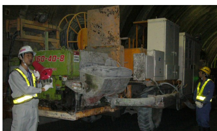
(コンクリート吹付け機研修)
