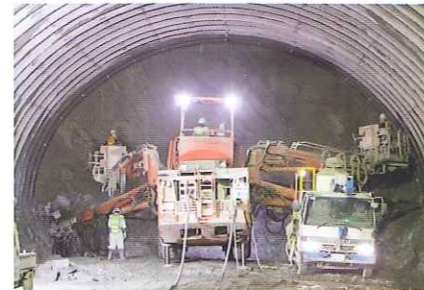
トンネルの最先端で作業するドリルジャンボ。 数人で連携しながら、火薬を装填し爆破する。
