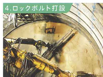
発破に使用したドリルジャンボによりトンネル天井部分等に扇状に穿孔し、ロックボルト(鋼棒)を差し込み、モルタルを注入することにより岩盤を補強します。
