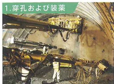
ドリルジャンボ(写真)により岩盤に孔を掘り、爆薬を孔に詰めて爆発させます。孔の深さは、通常1.0mから1.5m程度です。
