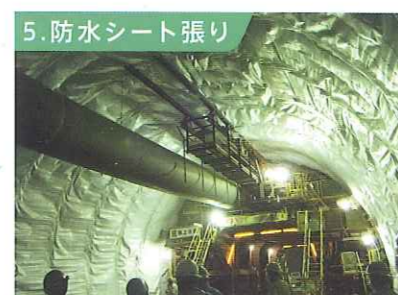
岩盤等地山からの水がトンネル内側に漏水しないように塩化ビニールシートを張ります。防水機能の他にもコンクリートクラック発生防止の機能もあります。
