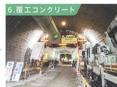
トンネル供用中に岩盤等が崩落しないようにコンクリートで岩盤を覆います。型枠は移動可能な鋼製セントル(写真奥)を使用します。コンクリートポンプ車(写真手前右側)を使用し打設します。
