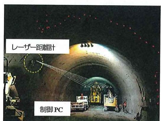
写真4 切羽押し出しリアルタイム計測
