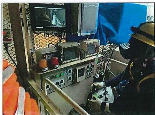
写真9 吹付けロボット遠隔操作状況
