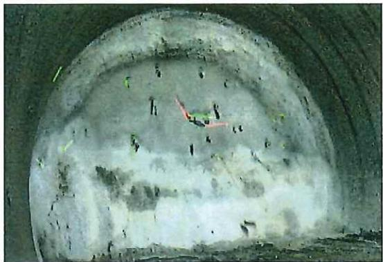
写真5 鏡クラック自動検知システム
