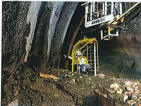
写真 11 マンゲージによる落石防護 (防護柵付き)
